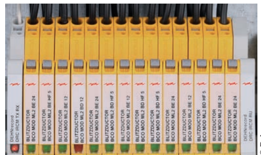
► Parafoudre combiné BCO ou BLITZDUCTORconnect de DEHN.
