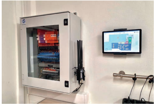
► Sensi'box incluant automate et cartes E/S.
