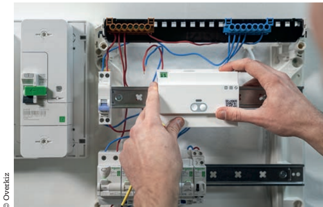
► Installation d'une passerelle Smartkiz d'Overkiz dans un tableau électrique.
